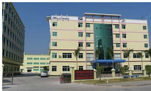
中国生産拠点(H17.11 完成)
